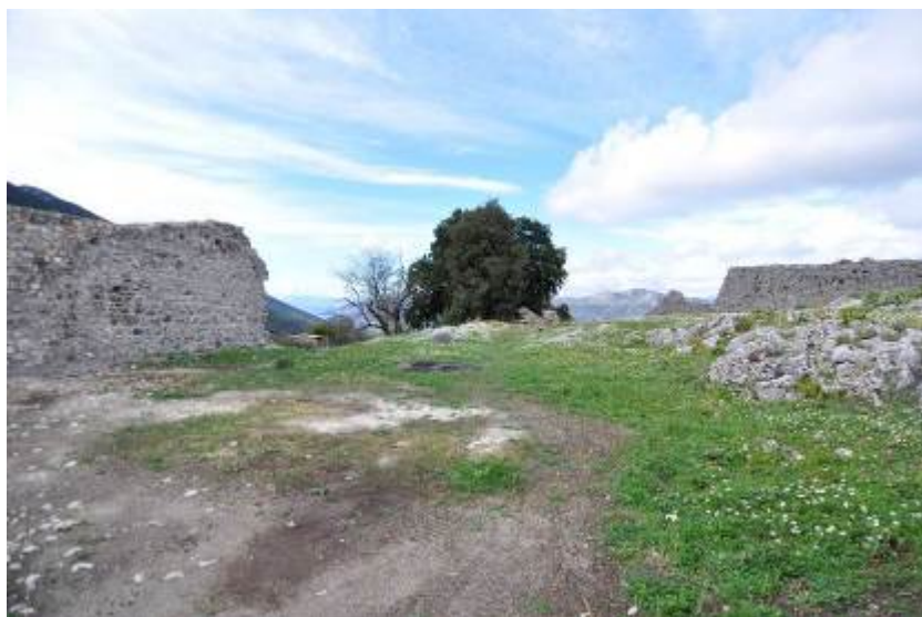
Εικ. 12 Δυτική (Δ) & Βόρεια (Β) εσωτερική πλευρά.
