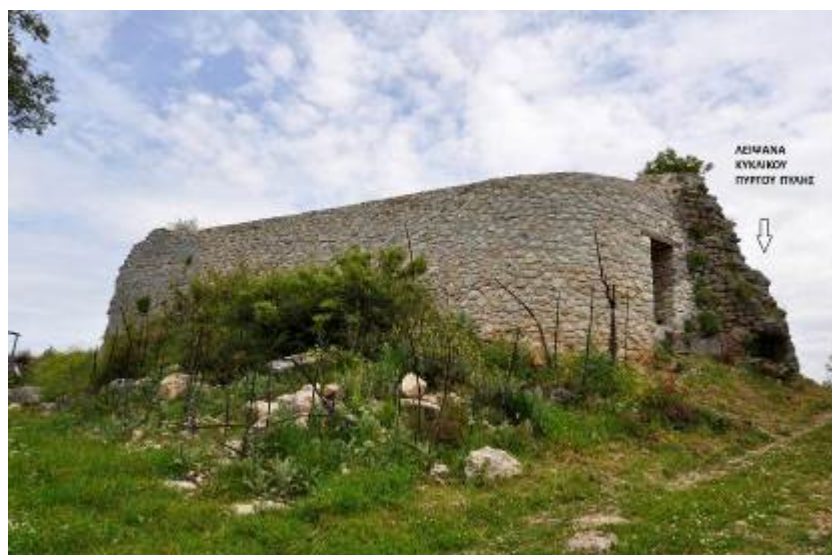
Εικ. 5 Δυτική (Δ) εξωτερική πλευρά: εργασίες αποκατάστασης (2022).
