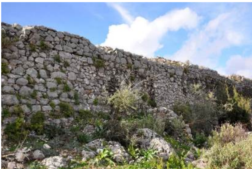
Εικ.10 Νοτιοανατολική (ΝΑ) εξωτερική πλευρά.
