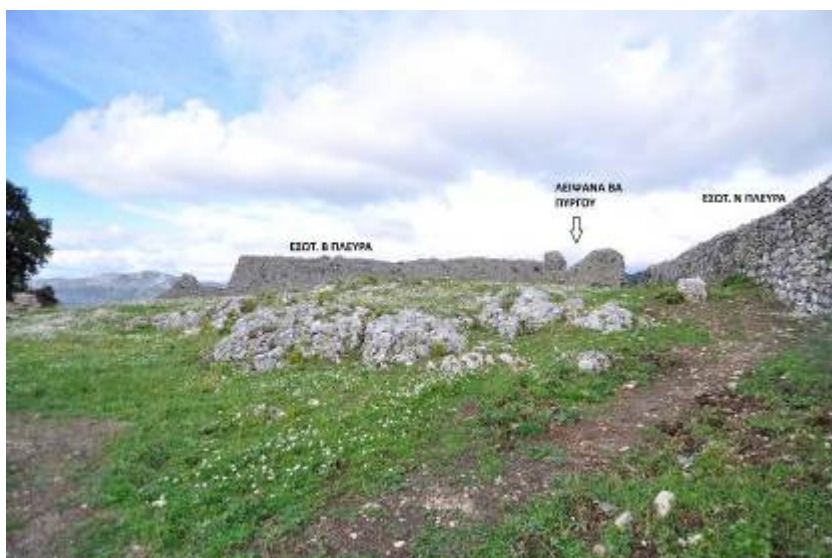
Εικ. 13 Βόρεια (Β) & νότια (Ν) εσωτερική πλευρά.
