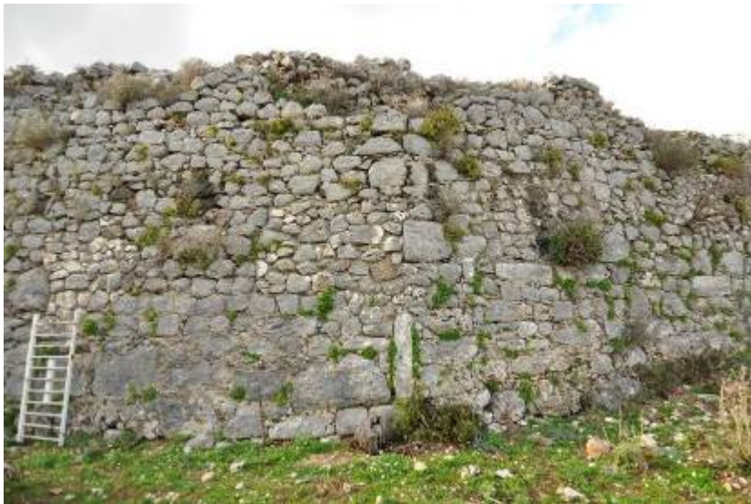
Εικ. 8 Νοτιοανατολική (ΝΑ) εξωτερική πλευρά.
