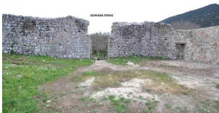
Εικ. 7 Νοτιοανατολική (ΝΑ) & δυτική (Δ) εσωτερική πλευρά: εσωτερική άποψη της πύλης και στα δεξιά το αποκατεστημένο τμήμα της δυτικής τειχοδομής κατά τις εργασίες του 2022.
